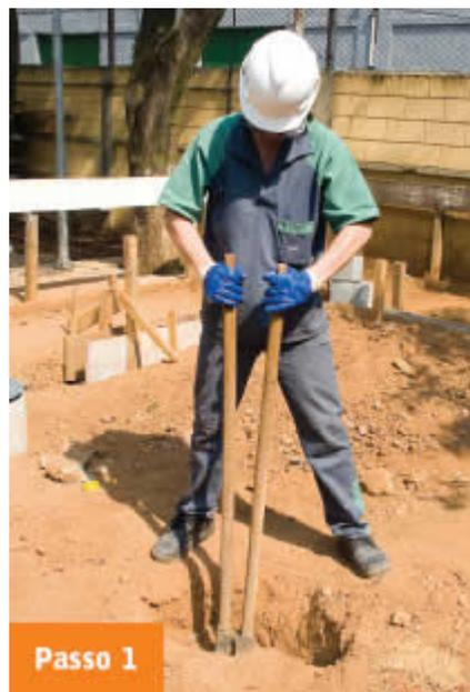
Com o auxílio da cavadeira, abra uma vala com diâmetro e profundidade suficientes para o encaixe da caixa de inspeção.
