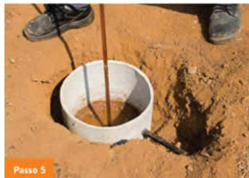
Retire a haste e repita os passos três e quatro até conseguir introduzi-la quase por completo no solo. Complete a cravação com golpes de marreta, interpondo entre ela e a haste um pedaço de madeira
