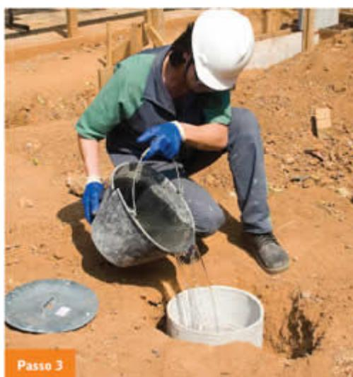
Preencha a vala com água para umedecer o solo. Isso facilitará a aplicação da haste cobreada de 2,40 m.
