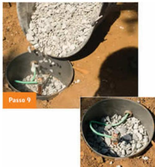
Preencha a caixa de inspeção com brita até uma altura onde ainda seja possível visualizar o conector. O uso da brita evitará que alguém inadvertidamente jogue concreto dentro da caixa, tornando o acesso ao conector e à haste impossíveis. Além disso, a brita ajudará a manter a umidade do solo próximo à haste.
