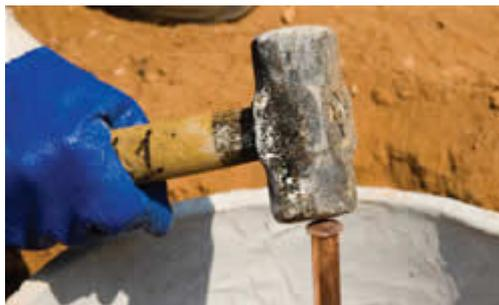
**Jamais bata diretamente a marreta sobre a haste cobreada! Além de retirar a película de cobre que a reveste, usar a marreta sem o auxílio do caibro danificará a cabeça da haste, impedindo a colocação do conector ou a sua substituição.**
