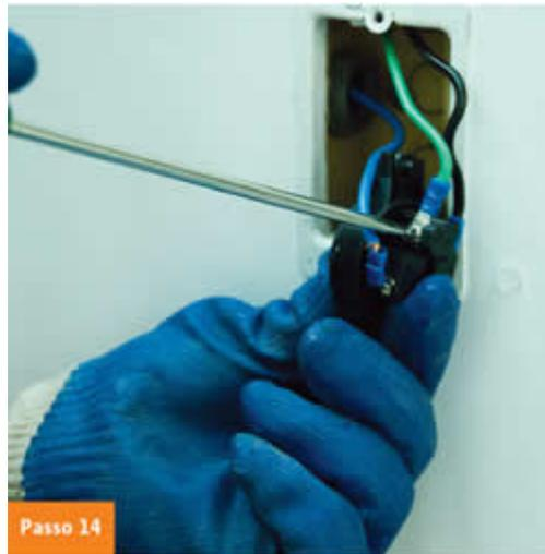
Com o auxílio da chave de boca, finalize o serviço conectando o fio terra no terminal de terra das tomadas e soquetes.
