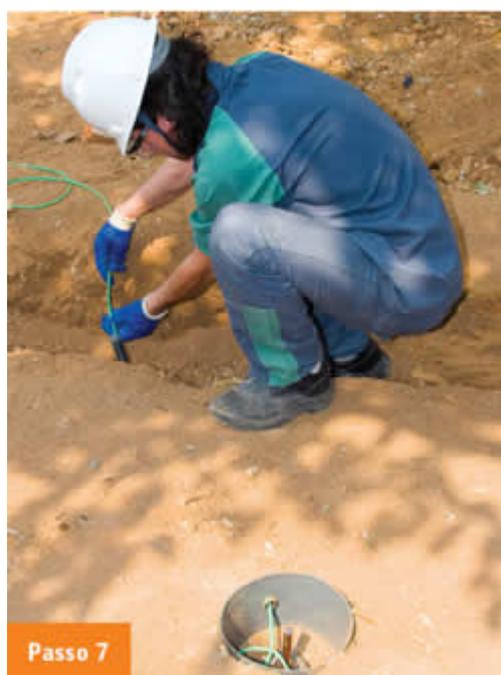
Passa o condutor de aterramento (fio terra) pelos tubos (eletrodutos) até chegar à caixa de inspeção.
