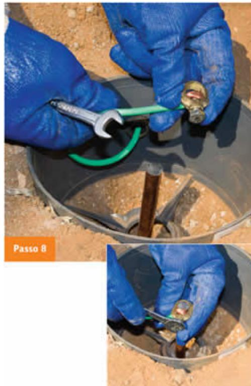
Com uma chave de boca 13 mm, faça a conexão do cabo à haste. Se necessário, use o canivete para decapar o condutor.
