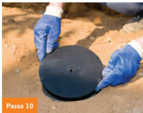
Finalize fechando a caixa de inspeção com a tampa.
