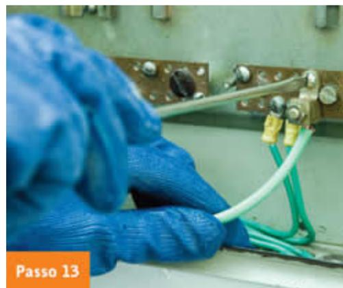
No quadro de distribuição, conecte o condutor de proteção no barramento de terra de onde sairão os demais fios terra a serem conectados aos pontos de eletricidade distribuídos pela residência.
