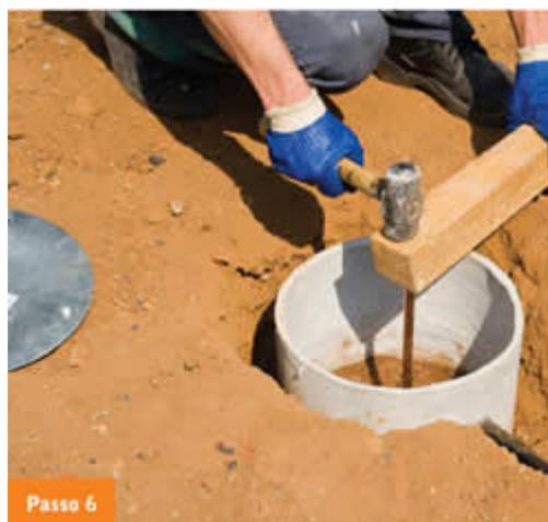
A haste deverá ser fixada até a metade da altura da caixa de inspeção.
