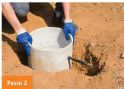
Acomode a caixa de inspeção no solo aplicando terra ao seu redor de modo a deixá-la totalmente firme e encaixada no chão.
