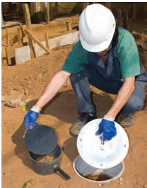
**As caixas de inspeção podem ser de fibrocimento ou de PVC.**
