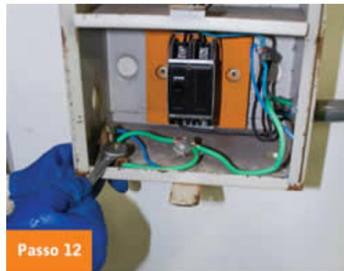
A partir desse ponto, derive um novo condutor (que agora passa a se chamar condutor de proteção) para ser conectado ao barramento do quadro de distribuição.
