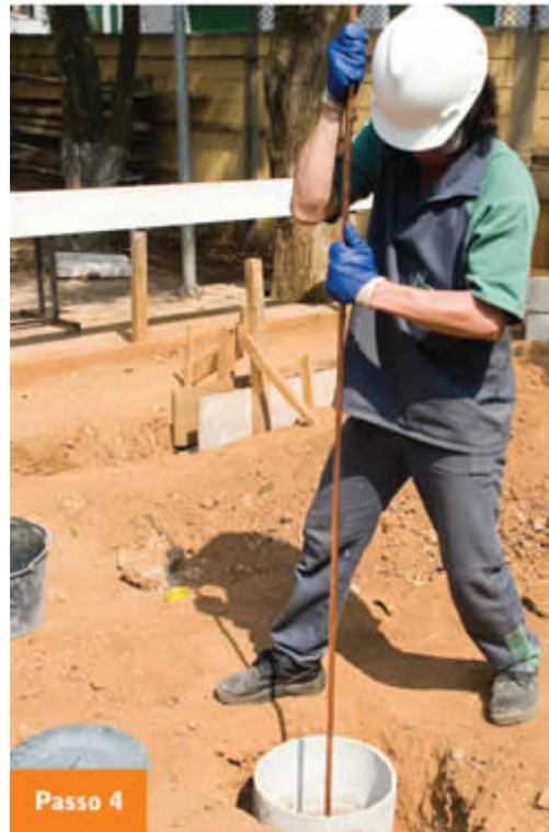
Utilizando muita força nas mãos, exerça pressão para cravar a haste cobreada no centro do diâmetro da caixa de inspeção.
