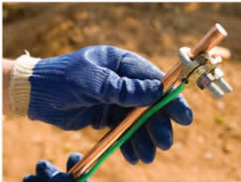
**Para condutores com bitola acima de 35 mm<sup>2</sup>, use o conector do tipo grampo.**
