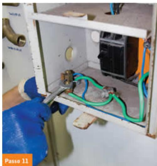
Com o auxílio da chave de boca e do canivete, faça a conexão do condutor de aterramento à caixa de entrada (caixa do medidor). O fio azul (condutor neutro da concessionária) também será ligado ao mesmo ponto.
